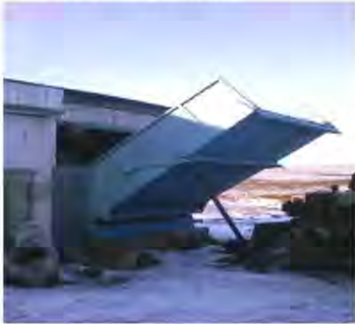
Мусоросортировочная линия на полигоне ТБО в пгт Камское Устье
