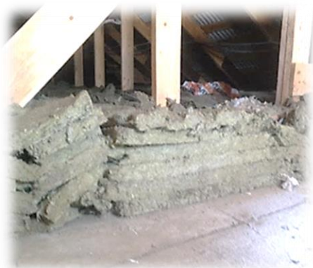
Некачественное выполнение работ по утеплению потолка в Тлянче-Тамакской школе-интернате Тукаевского муниципального района
