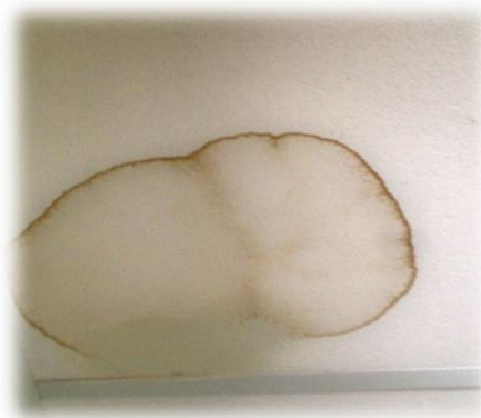
Некачественное выполнение работ по утеплению потолка в Тлянче-Тамакской школе-интернате Тукаевского муниципального района
